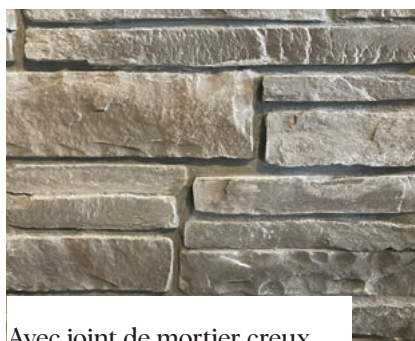
Avec joint de mortier creux
