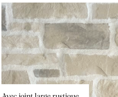
Avec joint large rustique
