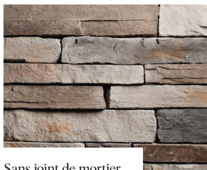
Sans joint de mortier
