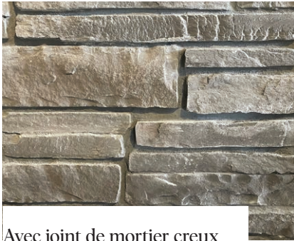
Avec joint de mortier creux
