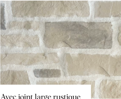
Avec joint large rustique
