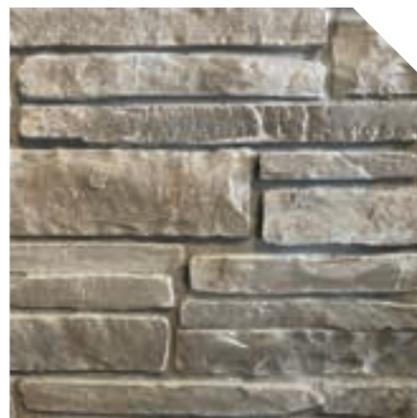
Avec joint de mortier creux
